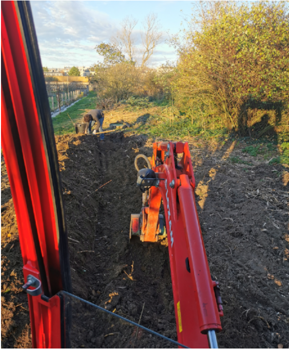
OUVERTURE DE TRANCHÉES POUR PASSER LA TERRE AU « PEIGNE FIN »
