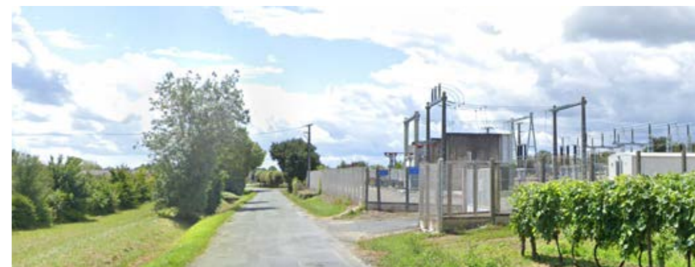
Entre, la route de Suchet, dépourvue de tout aménagement permettant de joindre les deux villages.
