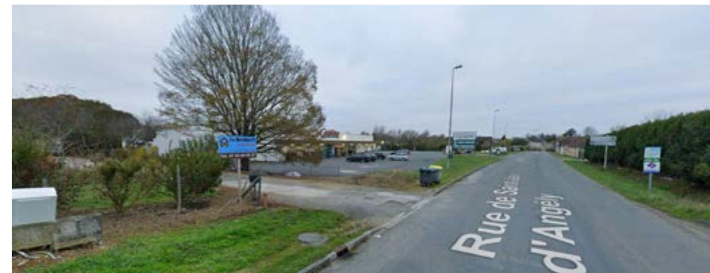
Des trottoirs interrompus au niveau du Casino...
