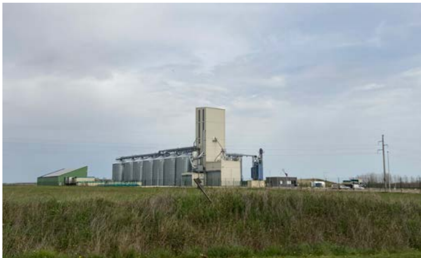
COP agricole depuis la rue de Saint-Jean d'Angely à Blanzac-lès-Matha
