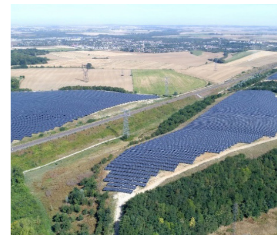
Centrale photovoltaïque des Gabots, Annet-sur-Marne, sur des installations de stockage des terres inertes de l'entreprise ECT, photo ECT
