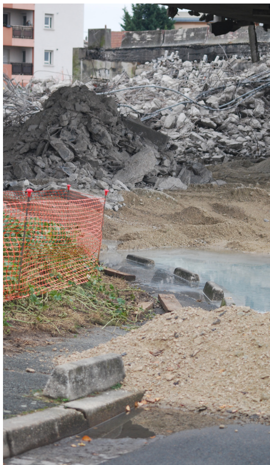
Démolition du pont de l'A186 à Montreuil, le béton du pont sera concassé pour le soubassement du futur tram T1, photo ML Garnier
