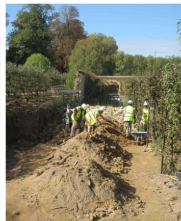
Au 5e des Onze, il y a un an, 35 mètres linéaires de mur se sont effondrés. Aujourd'hui les pierres sont triées, les gravats réutilisés pour tenir le talus, le bout du mur encore debout, étayé. En 2015, une nouvelle construction ou reconstruction sera réalisée. Merci à l'association Bleu oxygène développement.
