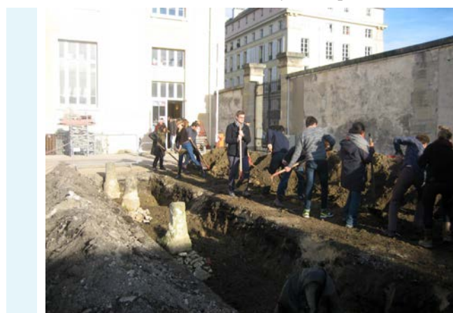
Un chasse-roue posé sur sa fondation et 19 m 3 de terre remblayés à la pelle !
