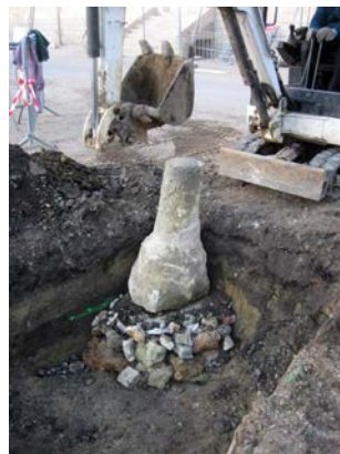
Un chasse-roue posé sur sa fondation et 19 m 3 de terre remblayés à la pelle !
