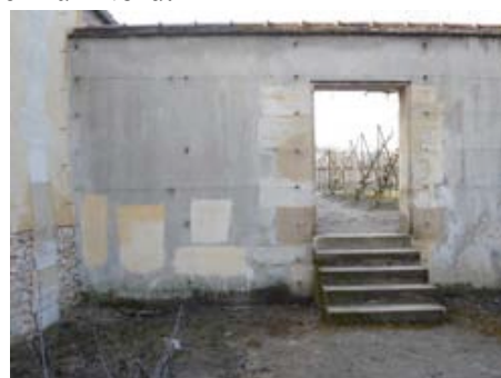
Essais de badigeons sur le mur exposé nord
