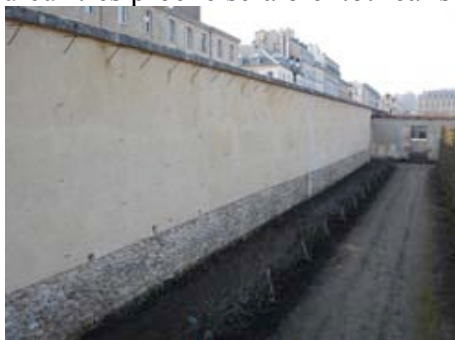
Le mur exposé ouest
