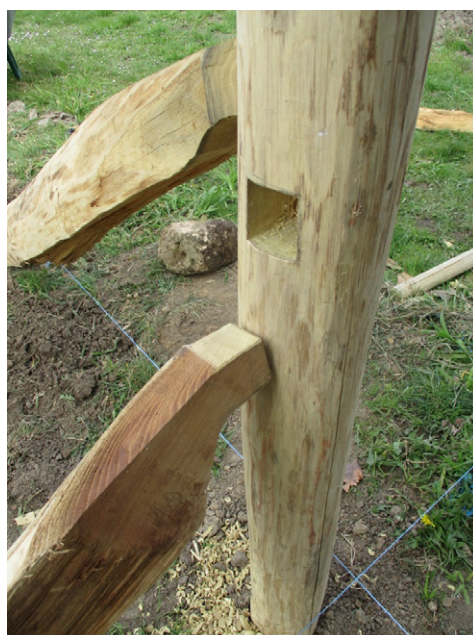
Assemblage de la jambe de force à son piquet par tenon-mortaise
