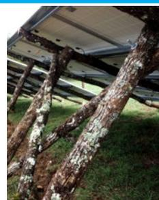
Charpente chêne fixée sur un pieu battu en chêne
