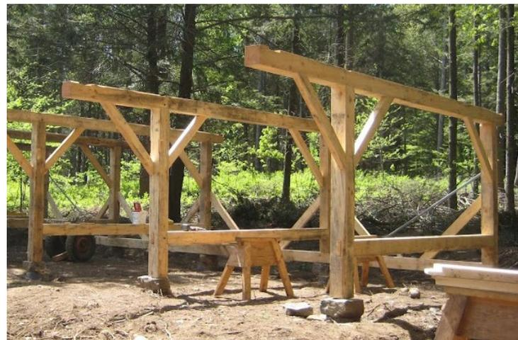
*Pose de fermes sur fondations en pierres sans béton.*
