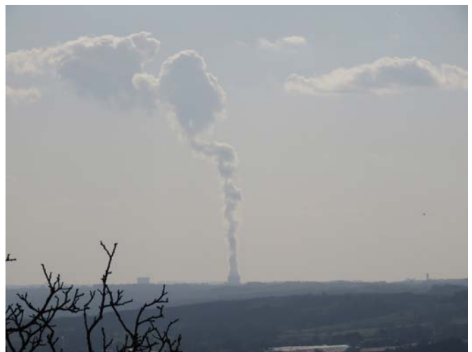
Vue sur la centrale nucléaire de Golfech
