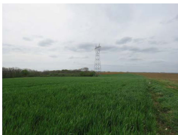
Vue depuis la parcelle sur le blé, le pylone et le boisement en contre-bas
