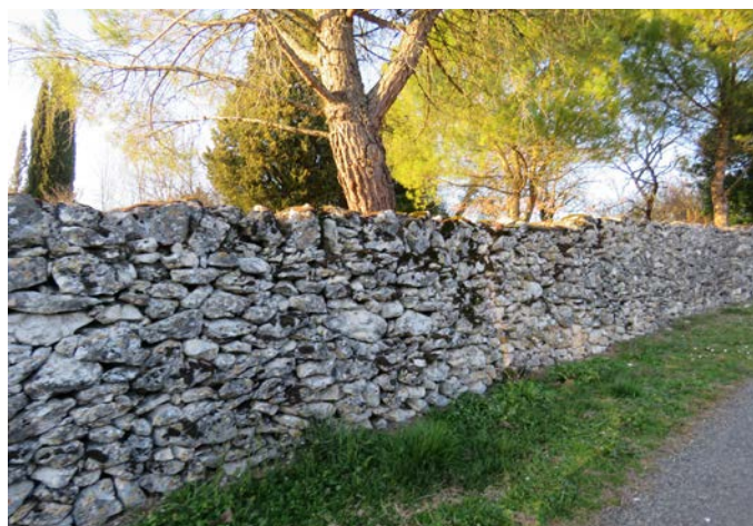
Mur traditionnel en pierre sèche
