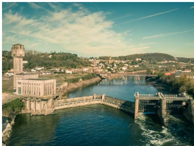
Centrale hydroélectrique de Fumel
