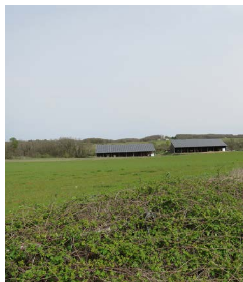
Vue depuis la parcelle vers les hangars photovoltaïques
