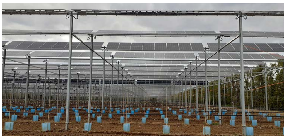
Exemple de dispositif pilote expérimental agrivoltaïque réalisé par SunAgri pour Fruits Auvergne-Rhône-Alpes à Etoile sur Rhône (26). Source : Photographie de Roxane Rahimi
