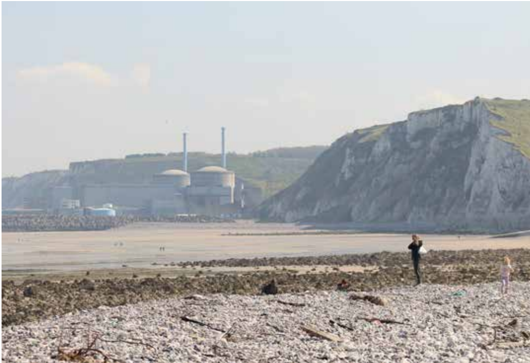
Centrale depuis plage de St Martin plage à marée basse
