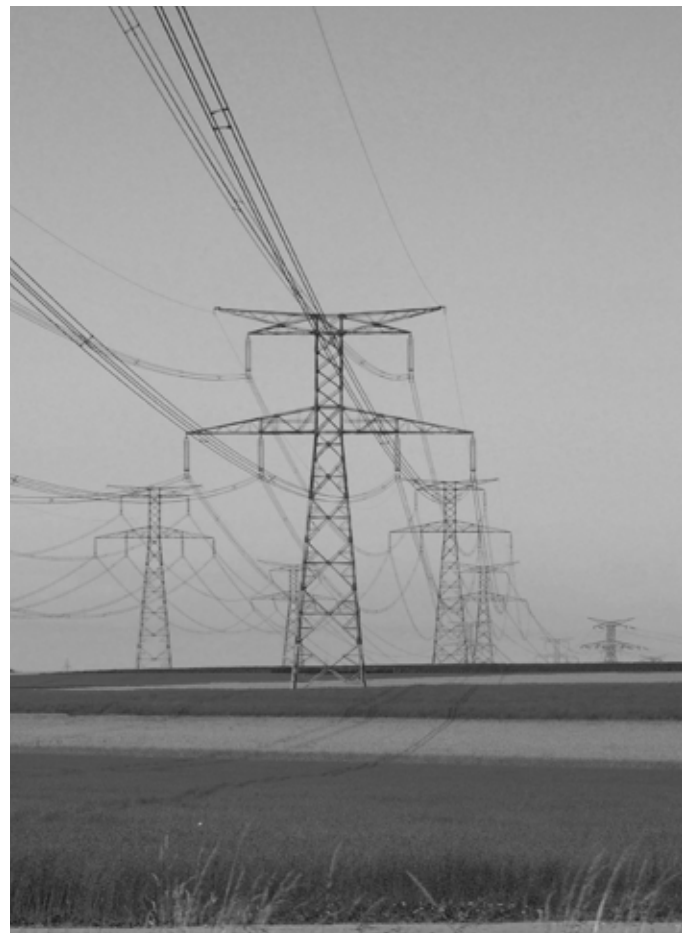
Les autoroutes de l'énergie, lignes tendues à travers la plaine cauchoise
