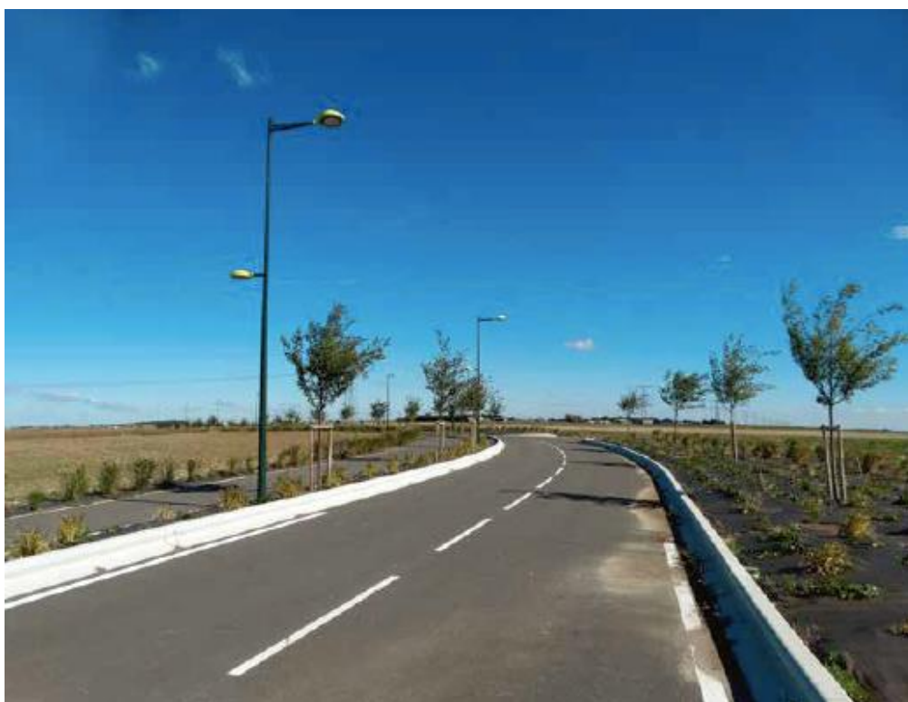
Figure 16. Aménagements paysagers de la ZA d'Escrennes (source : bilan du 1% A 19, Vinci Autoroute, 2019, p. 32)
