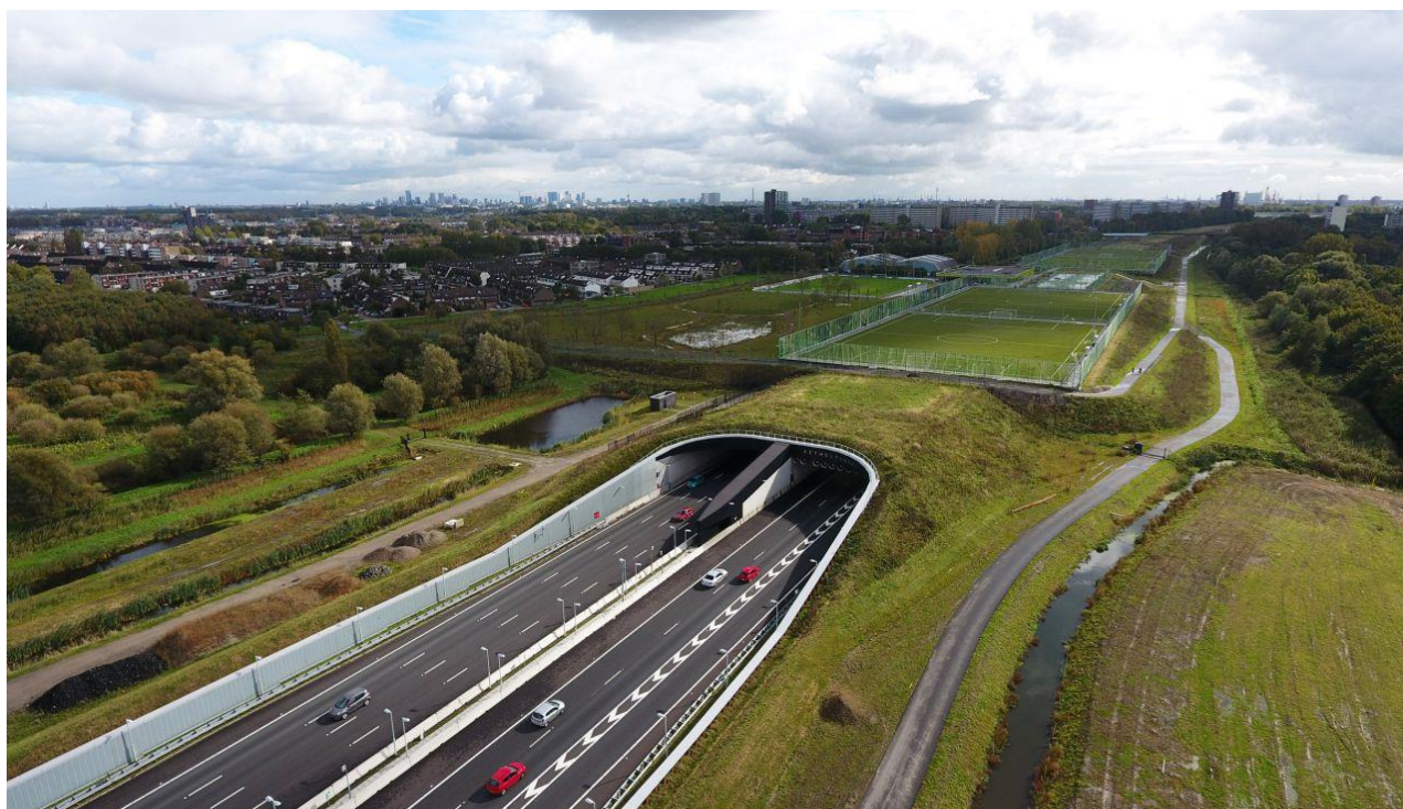
Figure 79. Photographie du tunnel de l'A4 A Schiedam. Source : https://www.arcadis.com/nl
