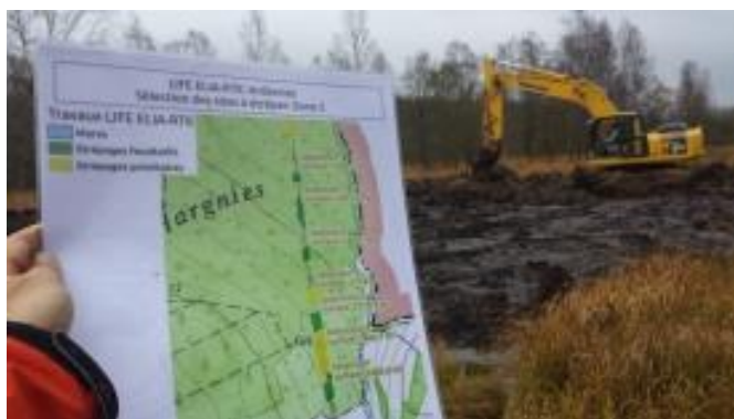
Figure 51. Chantier de réalisation de tourbières sur Hargnies (source : Life Elia-RTE)
