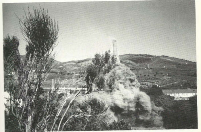
7 mai 1987 : démolition des cheminées (cliché Labroue)
