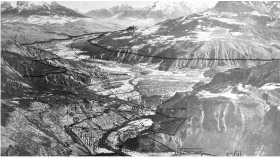
Tracé du projet de barrage sur une vue du site de Serre-Ponçon. Il a nécessité de remuer 14 millions de m<sup>3</sup> de terre et de rochers (soit six fois le volume de la grande Pyramide de Khéops.) et d'engloutir un village.
